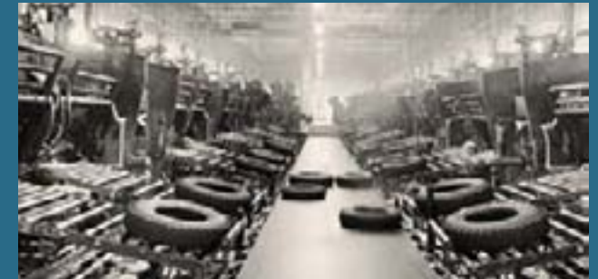
1970-luvun paistosali: Hakkapeliitit siirtyvät paistomuoteista kuljettimen hihnalle.
